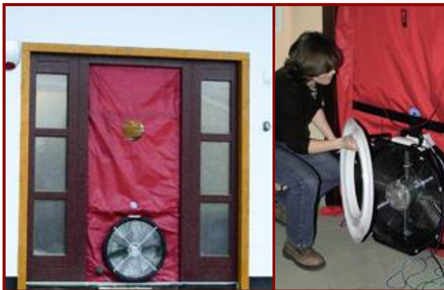
▲ Foto 5 - Il blower door test
