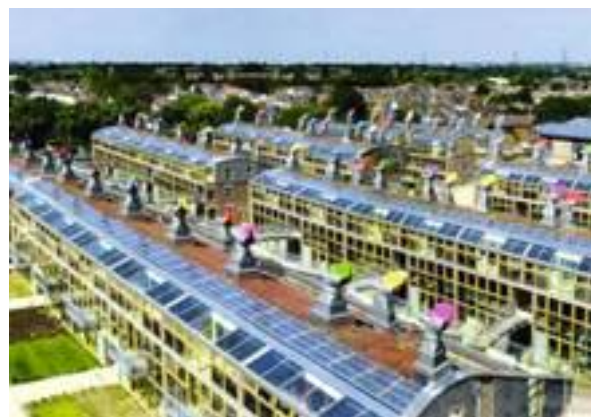
Figura 11 - Esempio di edificio a energia zero - Bedzed - Arch Bill Dunster - London Beddington 2001
