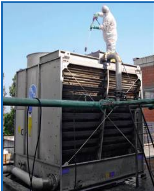
▲ Figura 5 - Esempio di intervento manutentivo con adeguati DPI
